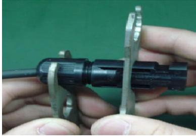
Schritt 4: Kontrollieren Sie die Polarität der Zuleitungen von den PV-Modulen an den Kupplungen. Verbinden Sie den den (+)-Pol der PV-Zuleitung mit dem Eingang für den (+)-Pol am Wechselrichter. Verbinden Sie den den (-)-Pol der PV-Zuleitung mit dem Eingang für den (-)-Pol am Wechselrichter.
