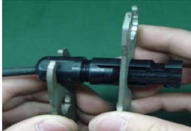
Schritt 4: Prüfen Sie die korrekte Polarität des Anschlusskabels von den PV-Modulen und den PV-Eingangssteckern. Verbinden Sie dann den Pluspol (+) des Anschlusskabels mit dem Pluspol (+) des PV-Eingangsanschlusses. Minuspol (-) des Anschlusskabels mit Minuspol (-) des PV-Eingangssteckers verbinden.
